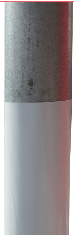
Folie schützt Fallrohr (z.B. bei Putzarbeiten)
